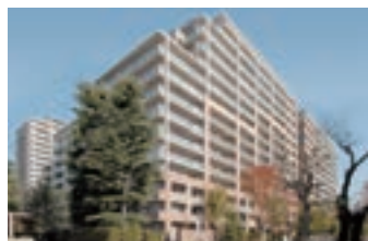
深沢ハウスHI棟
