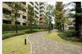
深沢ハウスHI棟
