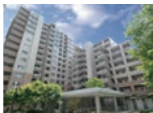
N 深沢ハウスHI棟
