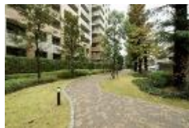
深沢ハウスHI棟
