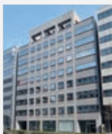
F 新川中央ビル
