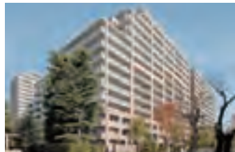
深沢ハウスHI棟
