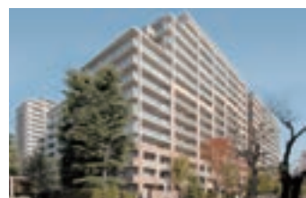
深沢ハウスHI棟
