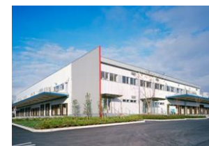
厚木南LC (A棟)
