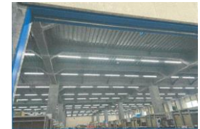
川口領家ロジスティクスセンター
