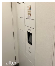
宅配ボックス設置
