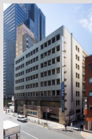
NMF新宿南口ビル
