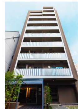
プライドフラット浅草橋Ⅲ
