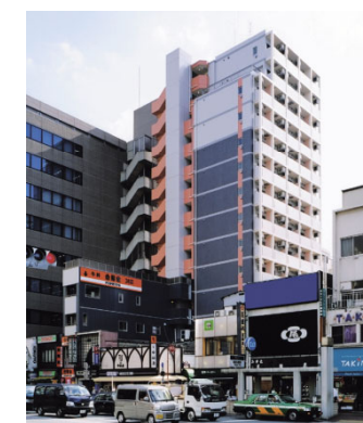
プライムアーバン飯田橋
