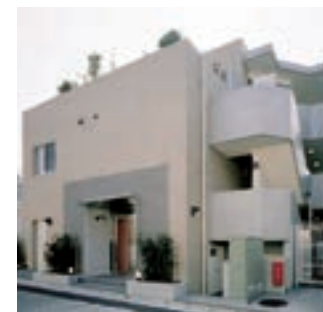
3 プラウドフラット初台 (東京都渋谷区)
