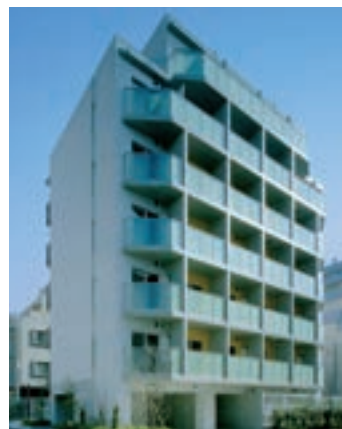
6 プラウドフラット目黒行人坂 (東京都目黒区)
