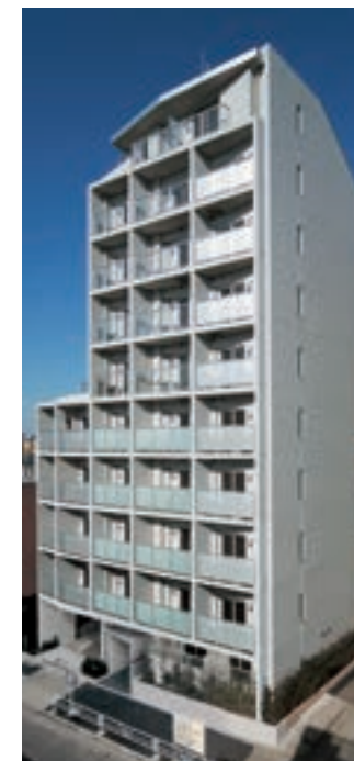
2 プラウドフラット代々木上原 (東京都渋谷区)
