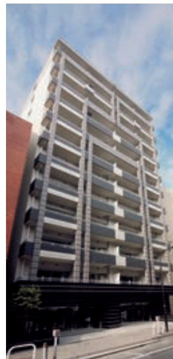
75 アーバンステージ日本橋横山町 (東京都中央区)
