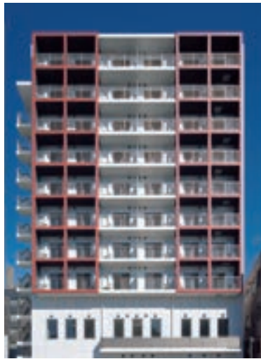
68 プライムアーバン川口 (埼玉県川口市)
