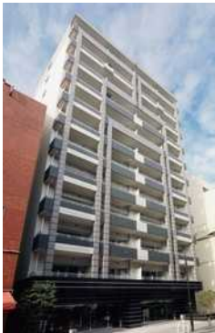
44 プライムアーバン 日本橋横山町
