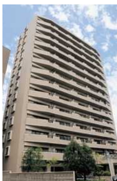
133 プライムアーバン堤通雨宮
