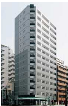
19 プラウドフラット浅草駒形
