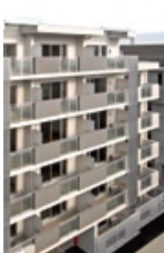
118 プラウドフラット河原町
