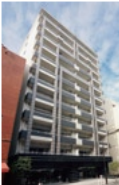
43 プライムアーバン 日本橋横山町
