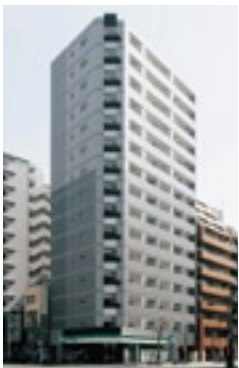
19 プラウドフラット浅草駒形
