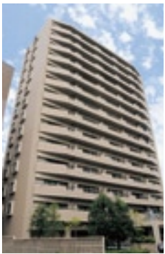
135 プライムアーバン堤通雨宮
