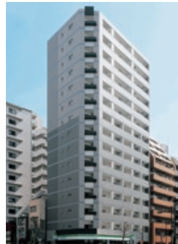
18 プラウドフラット浅草駒形 (東京都台東区)
