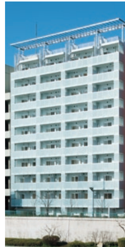
7 プライドフラット隅田リバーサイド(東京都中央区)
