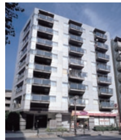
88 アーバンステージ大井町Ⅱ(東京都品川区)
