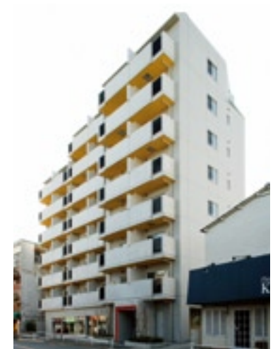
10 プラウドフラット新宿河田町 (東京都新宿区)
