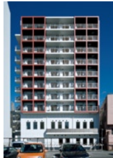
68 プライムアーバン川口 (埼玉県川口市)
