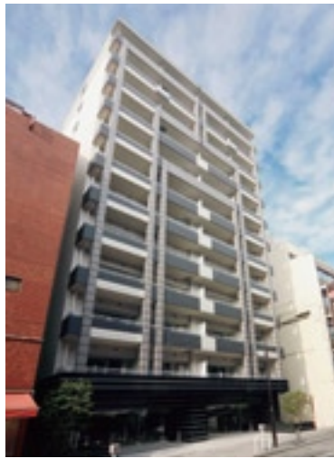
75 アーバンステージ日本橋横山町 (東京都中央区)
