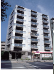
アーバンステージ大井町Ⅱ 地下室→事務所
