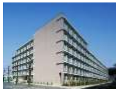
プラウドフラット上大岡 (総戸数200戸)
