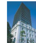
神戸海岸ビル
