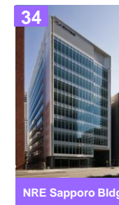
NRE Sapporo Bldg
