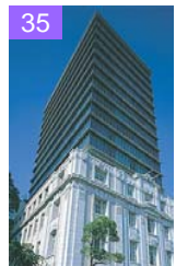
35 NOF Kobe Kaigan Bldg
