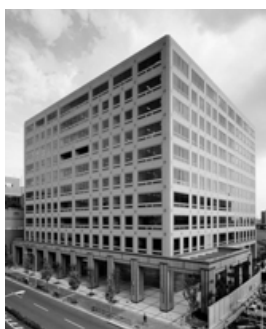
オムロン京都センタービル
