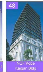
NOF Kobe Kaigan Bldg
