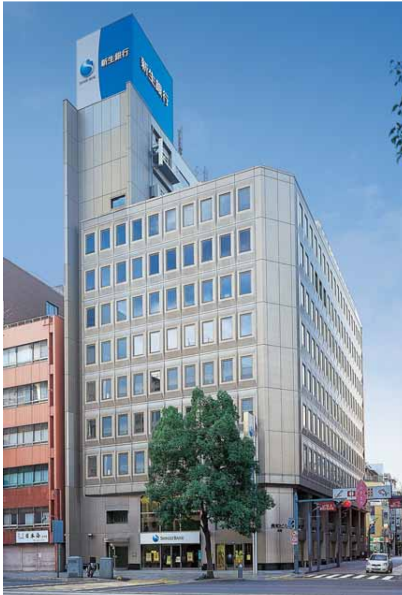
広島長和ビル外観写真
