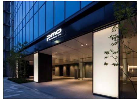
PMO日本橋江戸通 エントランス
