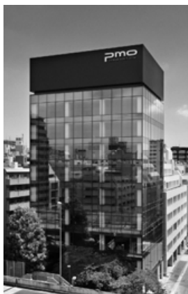
PMO日本橋本町
